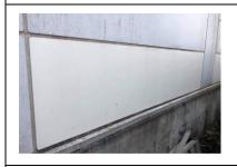
食品工場の外壁に部分的に試験施工頂きました。11ヶ月経過後のコントラストですがクロカビがまったく生成しないことに驚かれています。
