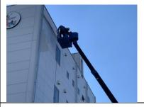
茅ヶ崎の海岸沿いレストランで窓ガラスに施工 頂きました。研磨という煩わしく高価な工程が 不要で、吹き付けるだけですので高所作業車で の工事も可能です。
