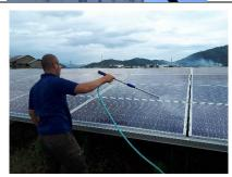
滋賀県のメガソーラーで、その効率維持の目的で施工頂きました。高い静電気除去機能で、ばい煙汚染以外に乾燥時のホコリ汚れも防ぐ効果があり6ヶ月で3%程度の効率差が確認できました。
