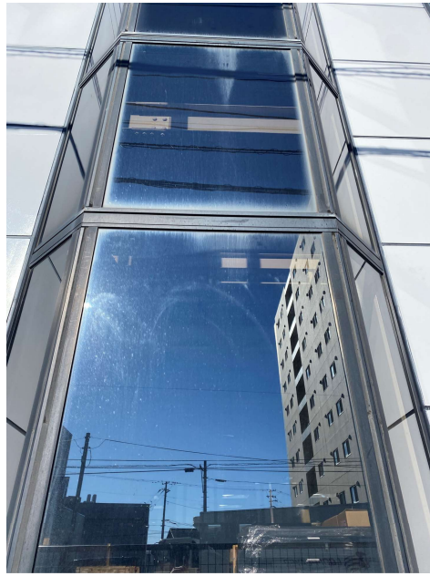
下地処理後(光触媒塗布後)
