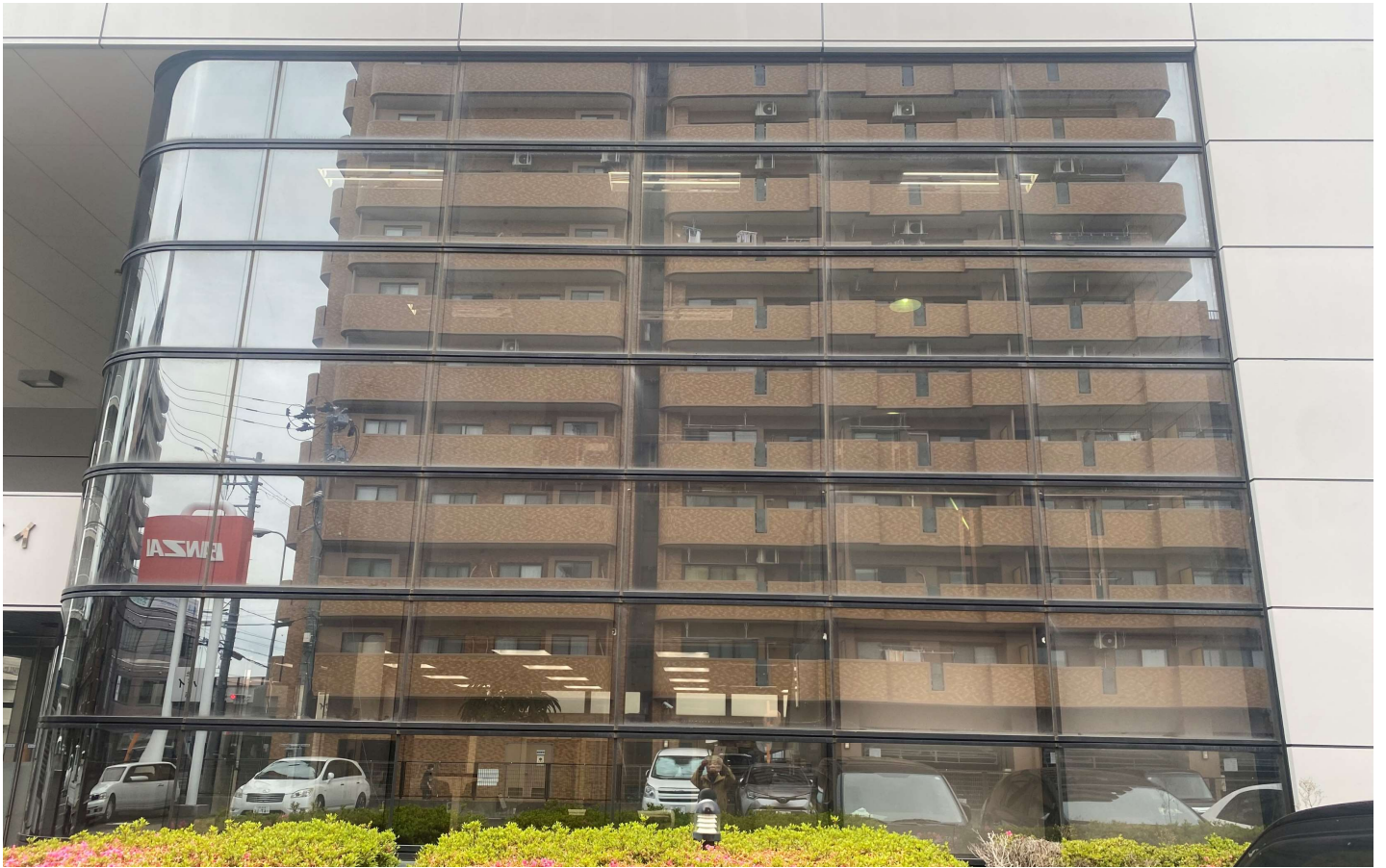
駐車場側外窓ガラス下地処理後(光触媒塗布後)
